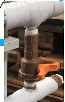
válvula Semi-aberta de distribuição e redução de pressão, permite que o sistema circule sem que ocorra excesso de pressão nos tanques.
